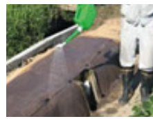
④散水・養生
