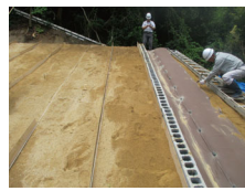
③マット敷設
